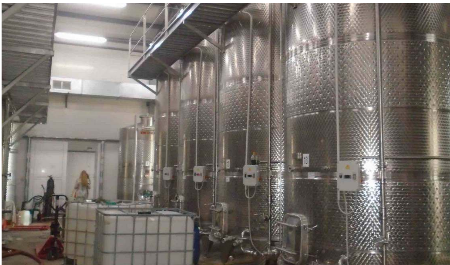
Сграда 2 - производствена площ
