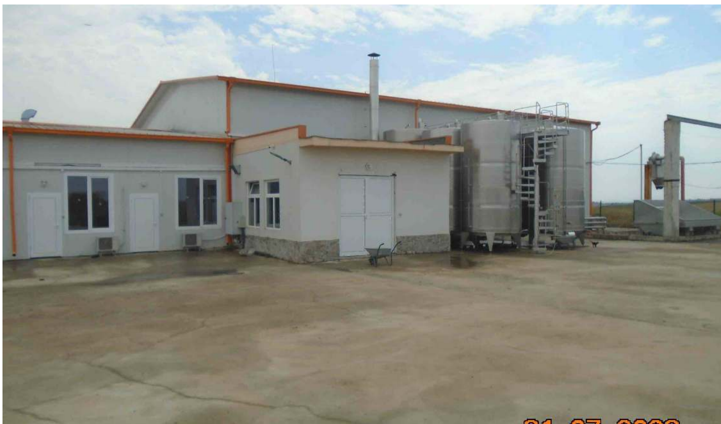
Сграда 2 - изглед от северозапад
