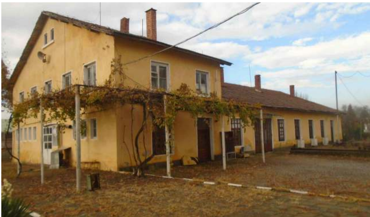
Изглед на сградата от югоизток
