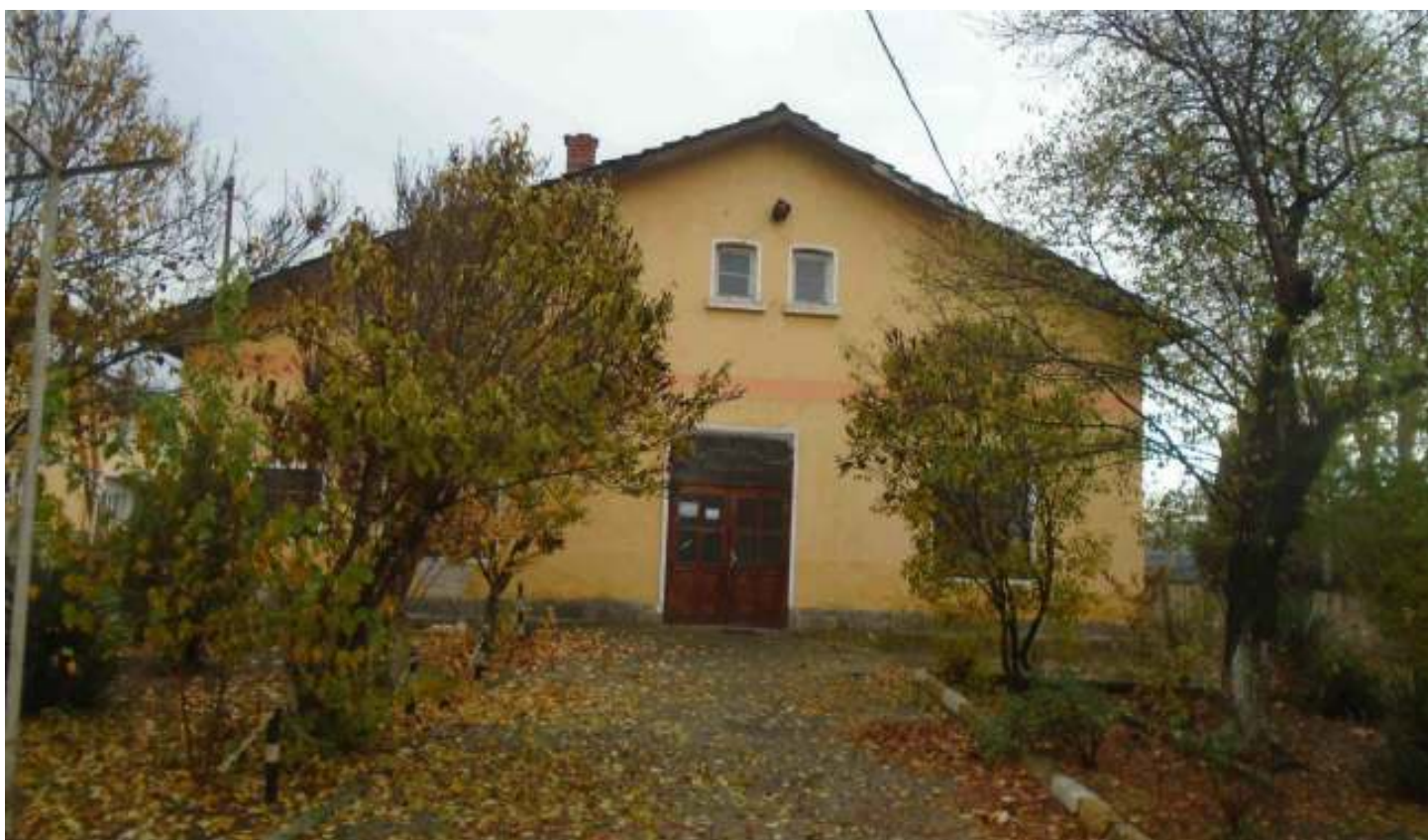
Изглед от север
